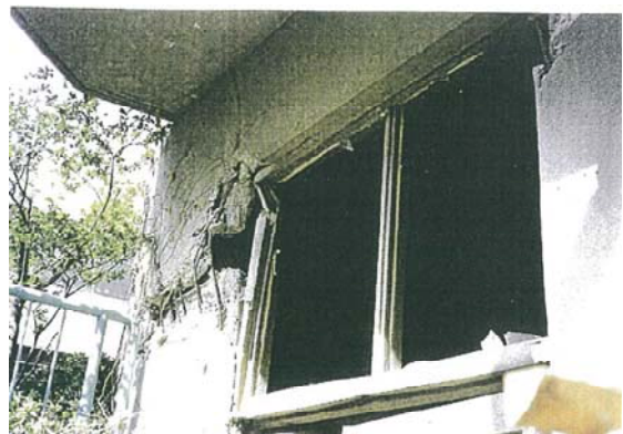
b) 短柱化した 1 階袖壁のせん断破壊状況
