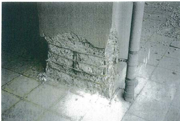
a) 1 階柱脚筋の座屈状況
